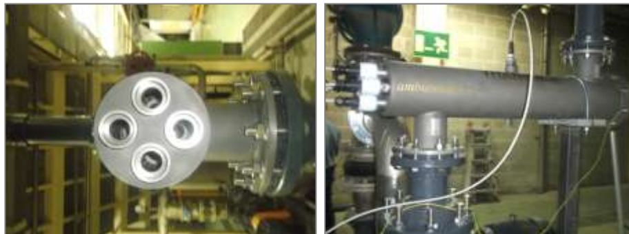
Reactor h2o.TITANIUM en paralelo a la bomba de recirculación, para tratar el agua de un depósito de 10 m3 con un caudal de recirculación de 163 m3/h y una renovación de agua de 4.5 m3/h.
